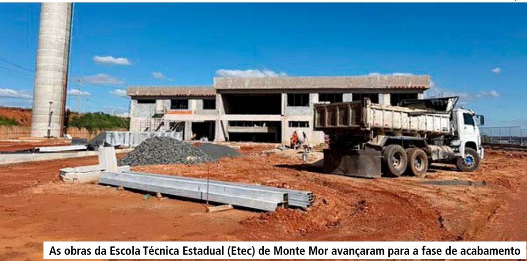
As obras da Escola Técnica Estadual (Etec) de Monte Mor avançaram para a fase de acabamento
